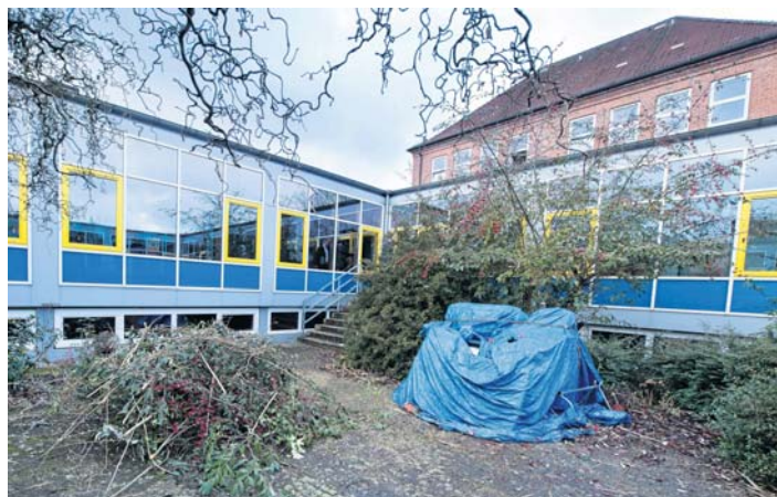
Das gut 300 Quadratmeter große Atrium, Anfang der 1960er-Jahre im Zuge des Schulbaus entstanden, wird heute kaum noch genutzt und ist mehr Abstellfläche.
